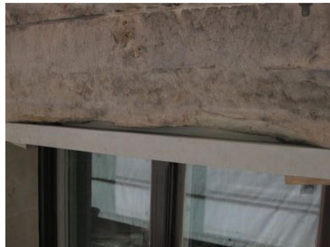
neue, L-förmige Sturzvierung, kraftschlüssig versetzt zur Wiederherstellung des Fensteranschlusses
