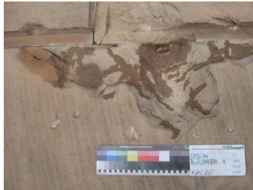
Sockelzone, Versorgung der Schusswunden, Anböschung mit Kiesel-schlamm, partielle Vorfestigung mit KSE
