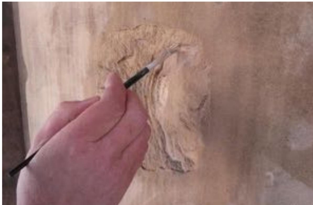
Sockelzone, Versorgung der Schusswunden, Anböschung Kiesel-schlamm mit Pinsel nach Vorfestigung mit KSE
