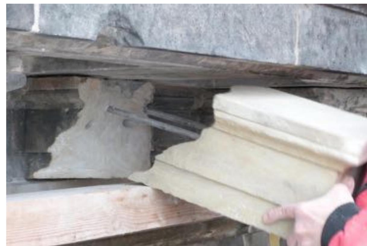
neue Konsole als 3D-Konturvering, Reinhardtsdorfer Sandstein mit V4A Gewindeanker
