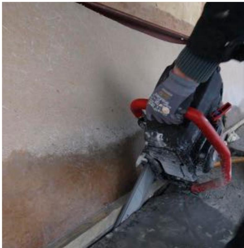
Attika, Schnitt mit Diamantkettenmotorsäge um neues Auflager für Winkelsteine herzustellen.
