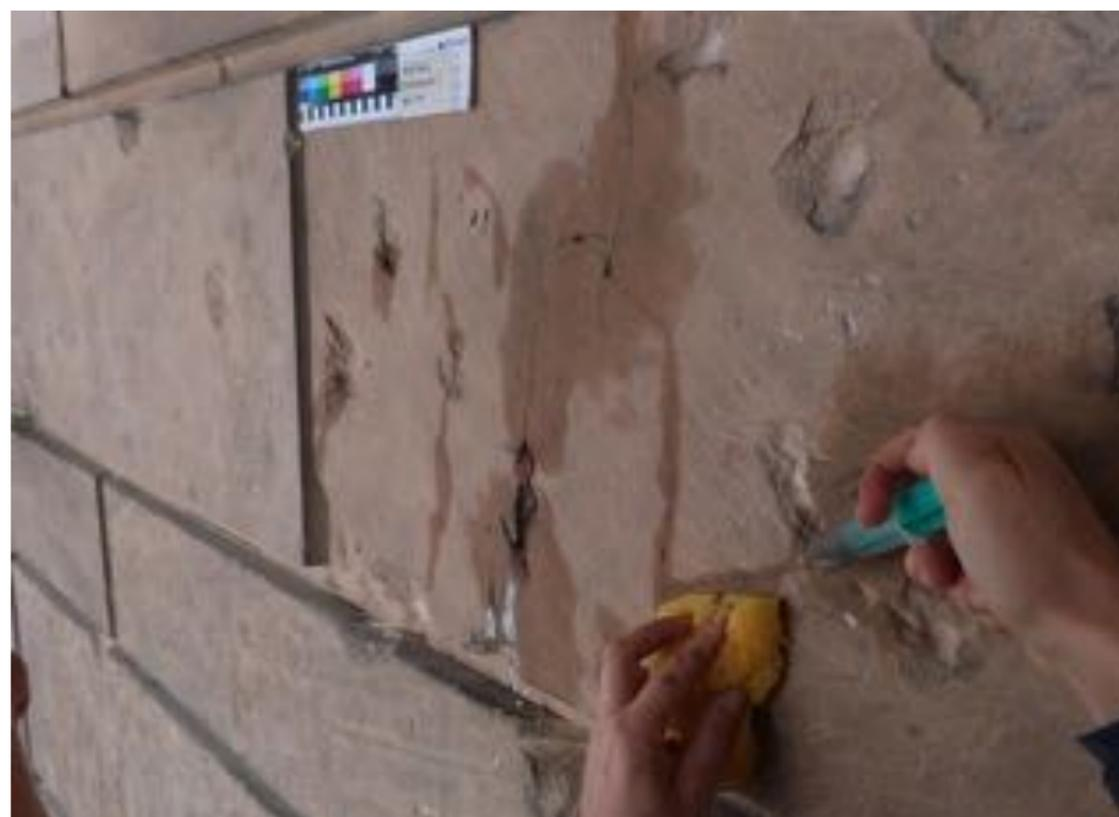
Sockelzone, Versorgung der Schusswunden, Anböschung mit Kieselstschlämme, partielle Vorfestigung mit KSE
