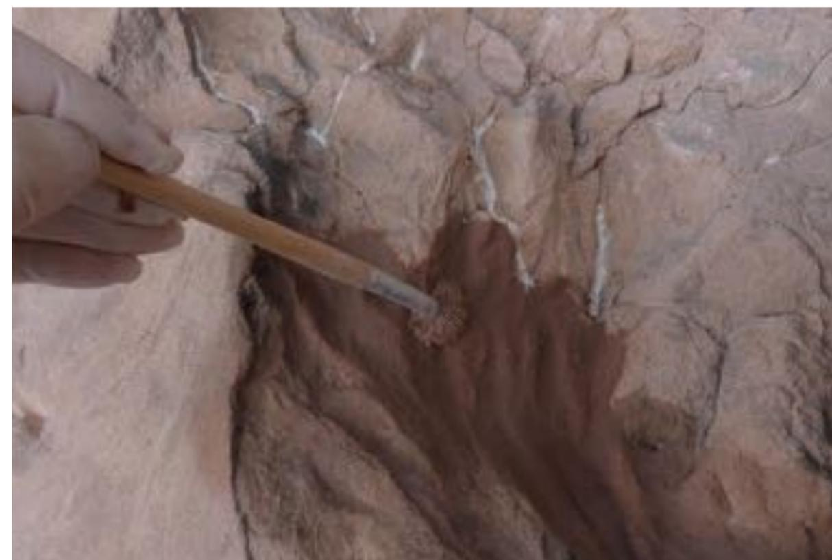
Sockelzone, Versorgung der Schusswunden, Anböschung Kieselstschlämme mit Pinsel nach Vorfestigung mit KSE
