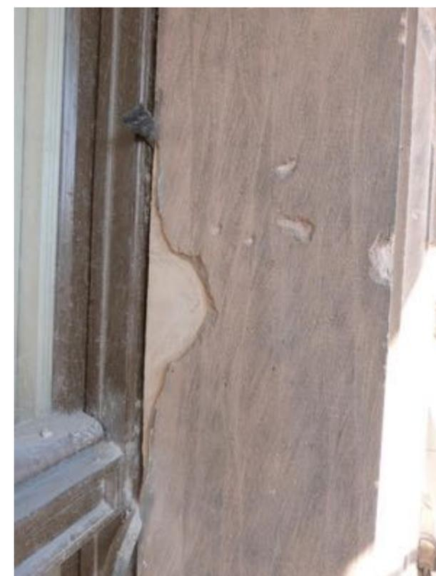
Konturvierung, Fensteranschluss vor Hartverfugung mit hinterlegtem Kompriband
